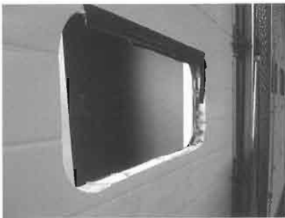
Das Sektionaltor war die Sicherheitslücke: Das Tor war nicht elektronisch überwacht, so konnten die Täter mit einfachen Hilfsmitteln das Fenster herausstemmen. Bilder: DESA/KDB
